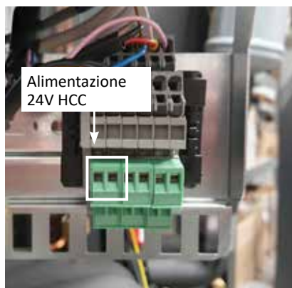
3b Morsettiera B2 – HCC – Segnale unità interna
