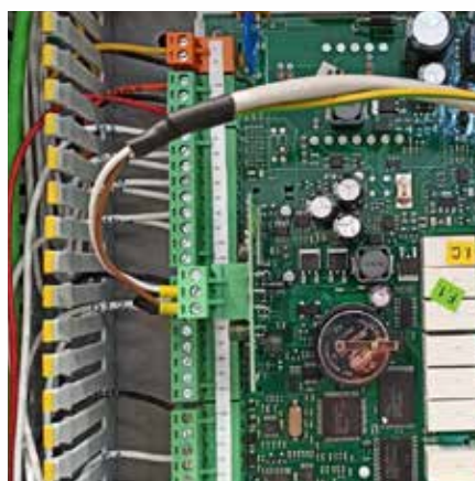
7b Particolare connessione uPC BMS
