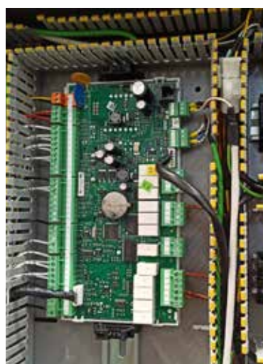
④b Particolare connessione μPC Plan
